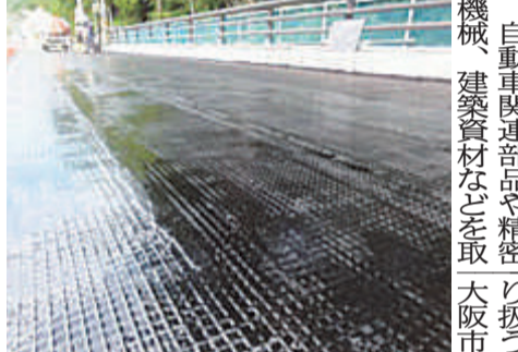
GGRW工法による床版補修
