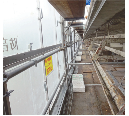
はね出し部の作業スペース
